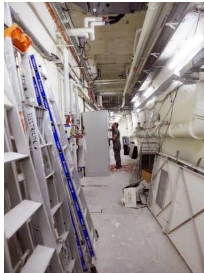
Interventions de mise en sécurité du sous-sol (recoupements, blocs-portes, SSI, éclairage, etc.)
