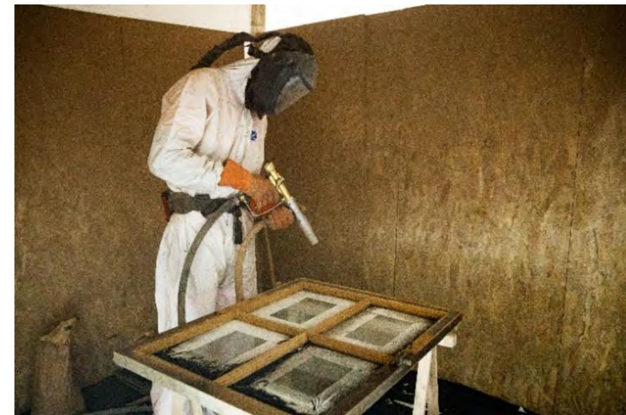
Déplombage et ponçage unité par unité après dépose des ouvrages
