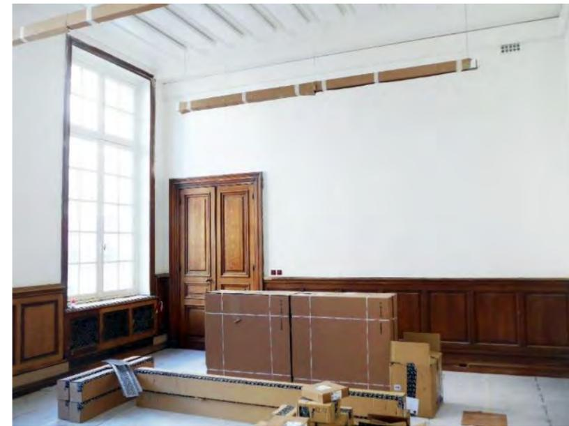
Pose des luminaires LED après pose des caissons acoustiques
