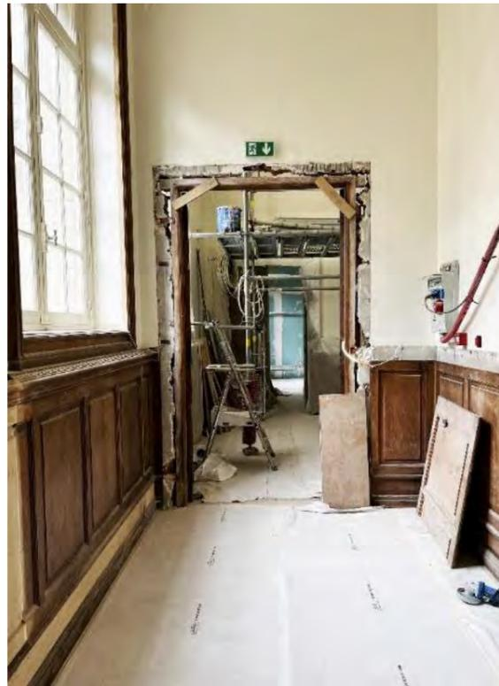
Refonte de l'installation Connectique (CFO/CFA/SSI), rénovation, remplacement ou reconstitution des boiseries, parquets, moulures et corniches du plafond sur l'ensemble des locaux de l'ancienne Ecole des Chartes
