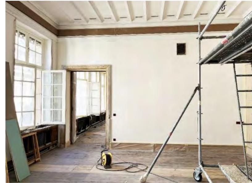
Préparation de la pose des panneaux absorbants dans les caissons du plafond et réparation-remplacement des allèges des baies vitrées
